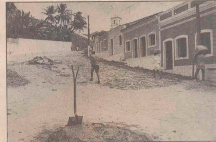
A prefeitura está empenhada na recuperação do calçamento
